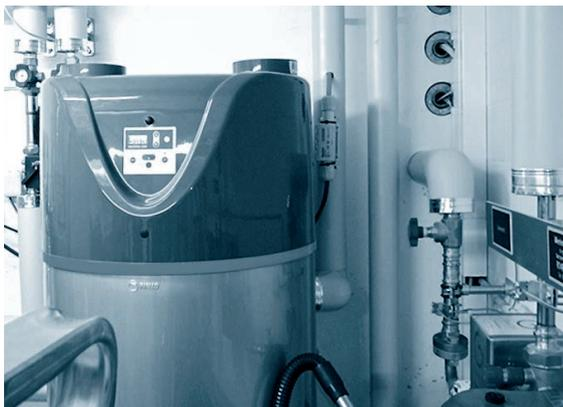
Der Einsatz eines Wärmepumpenboilers kommt nur dann in Frage, wenn dieser in einem unbeheizten Raum installiert werden kann (z.B. im Keller), da er der Umgebungsluft Wärme und Feuchtigkeit entzieht.
